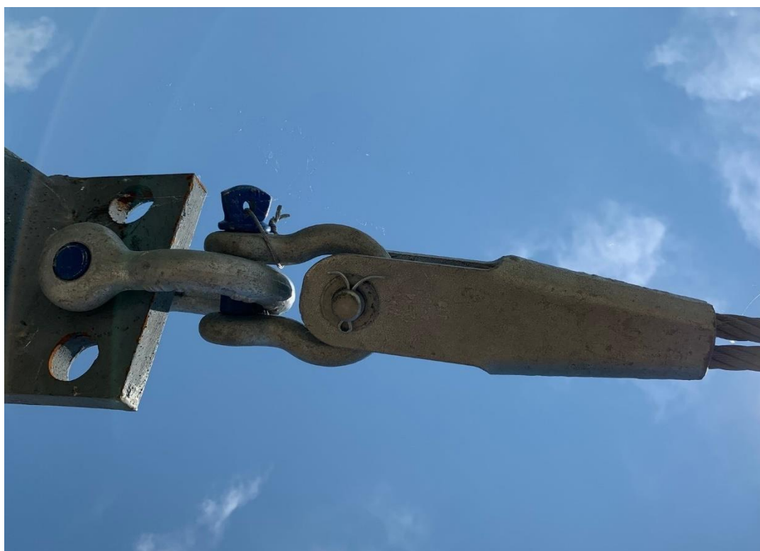
Figure 1 : Fixation d'un câble avec une serrure de câble et une manille de corde
