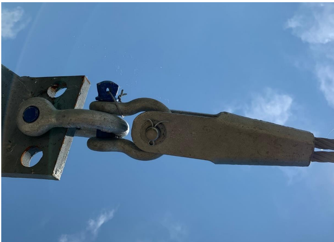
Bild 1: Seilverbindung mit einem Seilschloss und Schäkel
