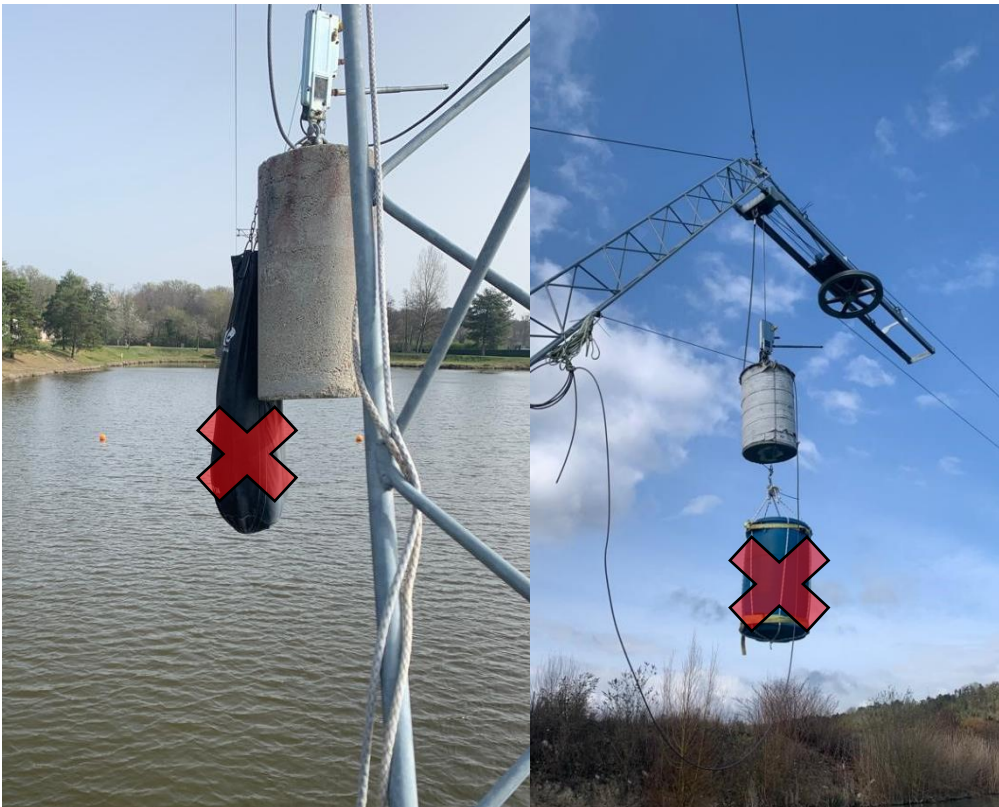
Bild 3: Spanngewicht, negativ Beispiel
